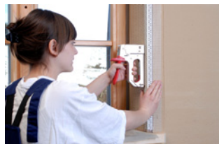
↓ Eckwinkel montieren ↓
