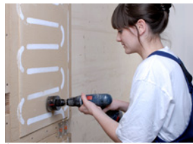
↓ Unterputzdosen einbohren ↓
