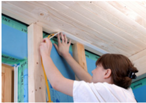
↑ Dichtungsband/Trennlagenpapier ankleben ↑
