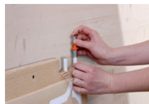
↑ Presskupplung ganz aufsetzen ↑
