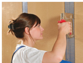
↑ Fugenarmierungsgewebe in Flachkanten eintackern ↑
