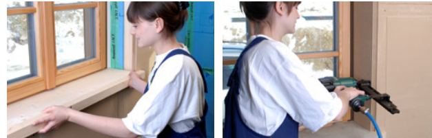
↑ Fenstersims einsetzen ↑
